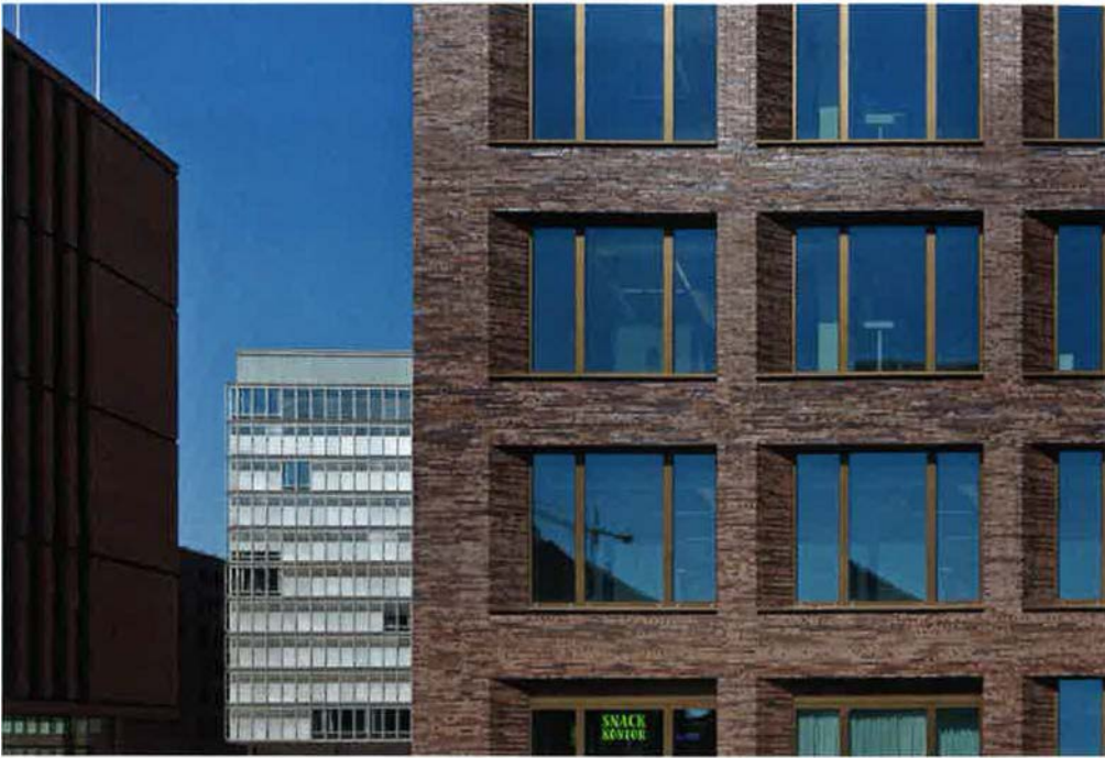
Die handwerklich, in Sonderformaten präzise ausgeführten angeschrägten Fensterlaibungen ermöglichen einen erhöhten Tageslichteinfall und sorgen so für qualitätvolle Räume.
