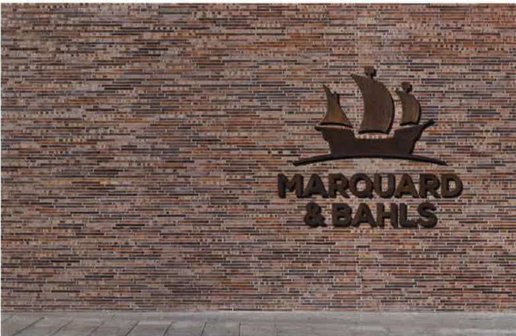
Durch den wilden Verband, die unterschiedlichen Klinkerformate und die Feingliedrigkeit der Backsteine in verschiedenen Erdtönen entsteht ein lebendiges Fassadenbild.
