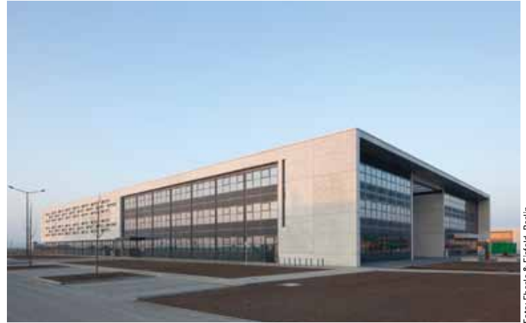
In Ost- und Westrichtung kragt die Betonfassade um 2 m aus. An den Seiten befinden sich hinter den Glasfassaden Büros, die Umkleiden liegen hinter den geschlosseneren Fassaden aus Betonfertigteilen
