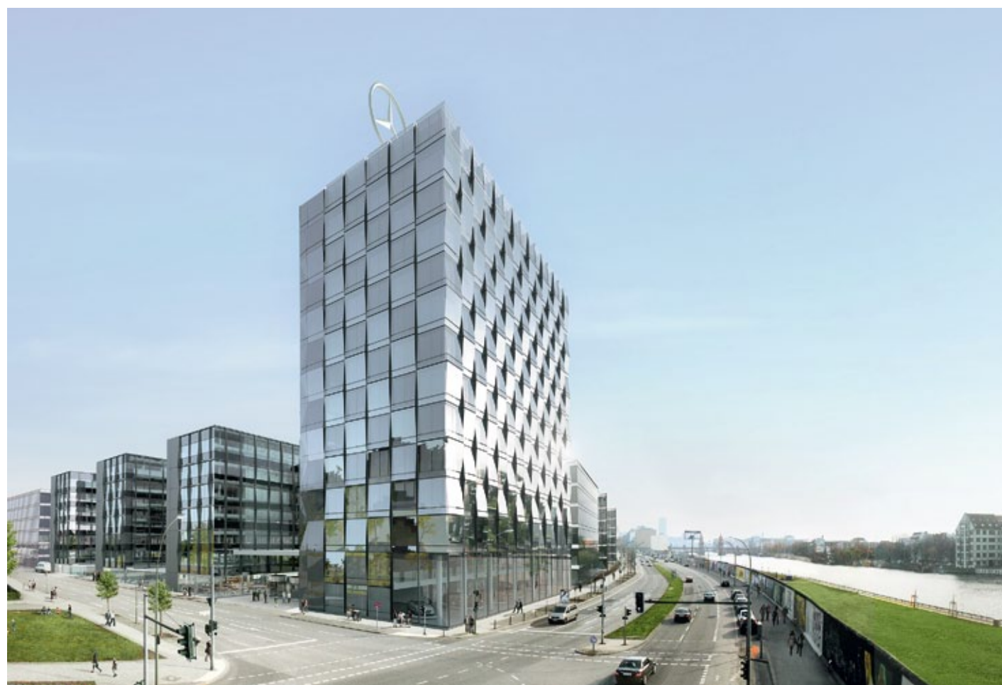
Zentrale Mercedes-Benz Vertrieb Deutschland, Berlin, im Bau, Fertigstellung 2013 (o.)
